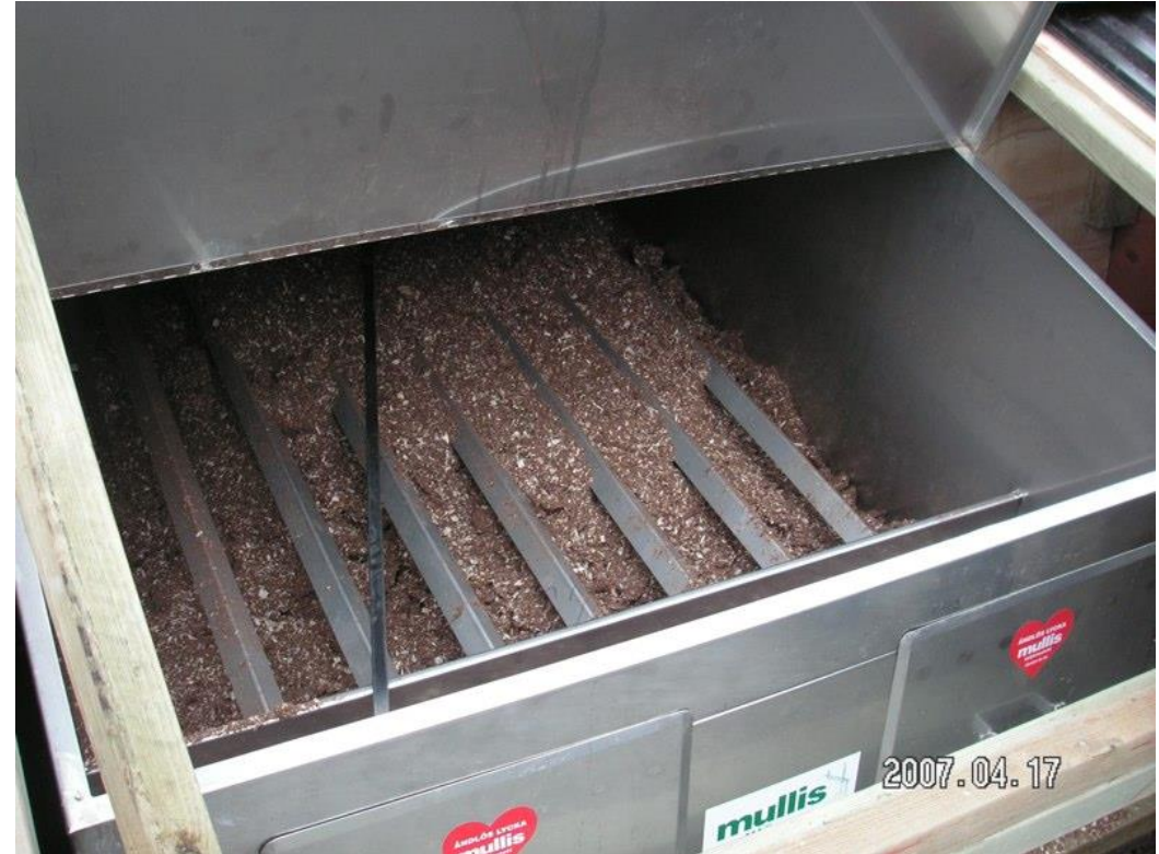
Mullis käymälä sisältä – näkyvissä ilmastointiputket ja kuiviketta.
