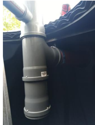
Ilmastuslautanen (2-3 kpl) Tulevan jäteveden putkisto Näytteenottoaivo Mammut-putkisto
