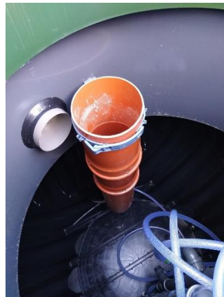
Ilmastuslautanen (2-3 kpl) Tulevan jäteveden putkisto Näytteenottoaivo Mammut-putkisto
