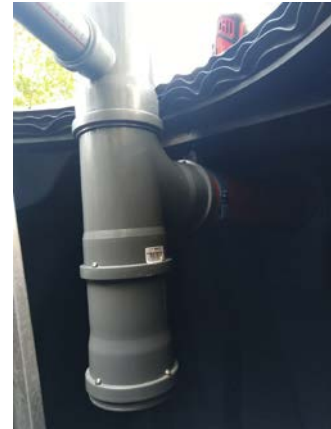
Ilmastuslautanen (2-3 kpl) Tulevan jäteveden putkisto Näytteenottoaivo Mammut-putkisto
