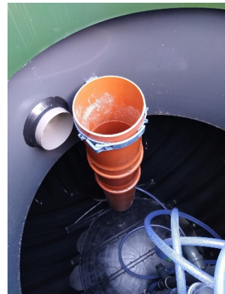
Ilmastuslautanen (2-3 kpl) Tulevan jäteveden putkisto Näytteenottoaivo Mammut-putkisto
